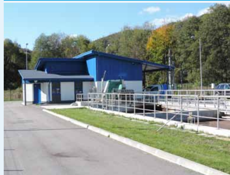
Čistiareň odpadových vôd
