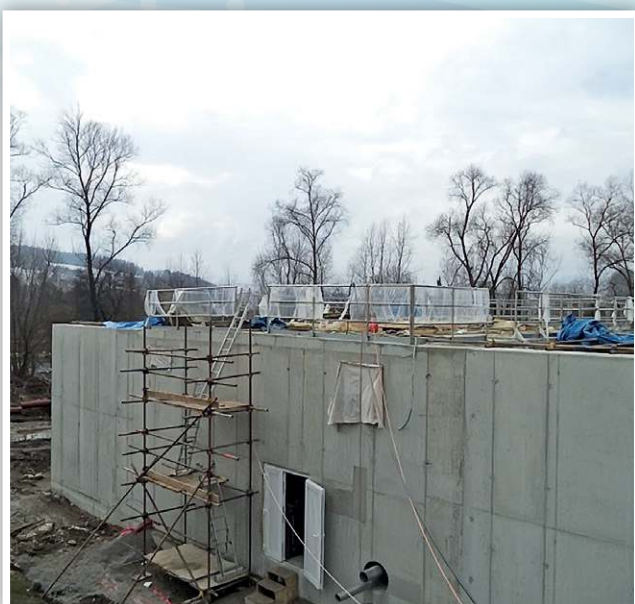
Rekonštrukcia ČOV Liptovská Teplá
