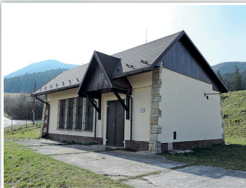
Vodárenský objekt Kosovo – Malá vodná elektrárň
