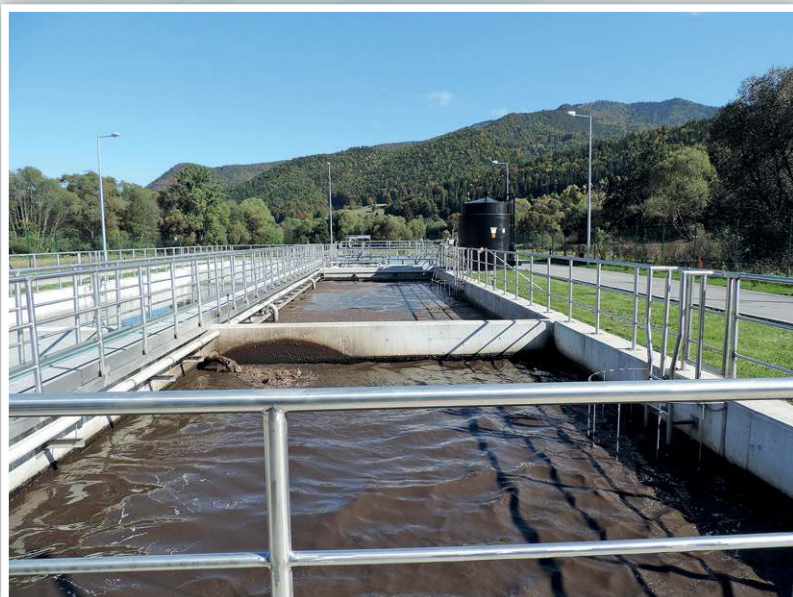
ČOV Liptovská Osada
