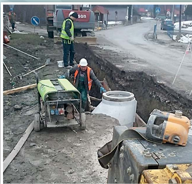
Výstavba verejnej kanalizácie v Liptovských Sliačoch
