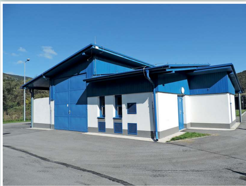
ČOV Liptovská Osada
