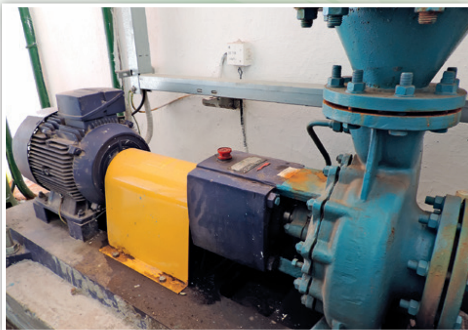
Vodárenský objekt – MVE Biely Potok
