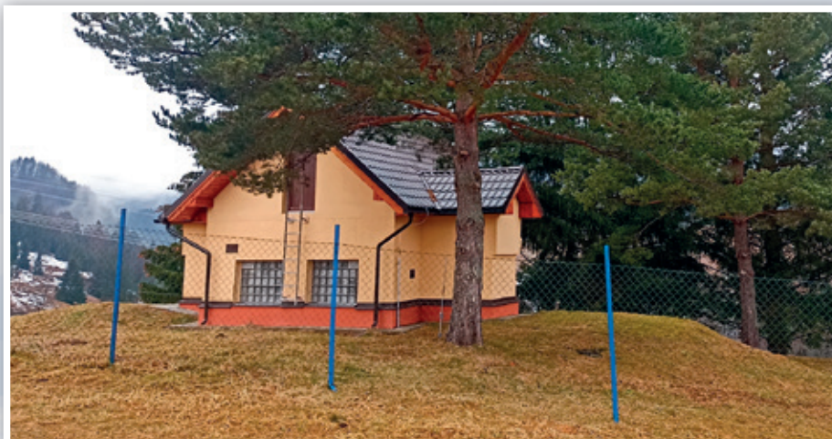
Vodárenský objekt – Vodojem Liptovská Osada 2x100 m 3
